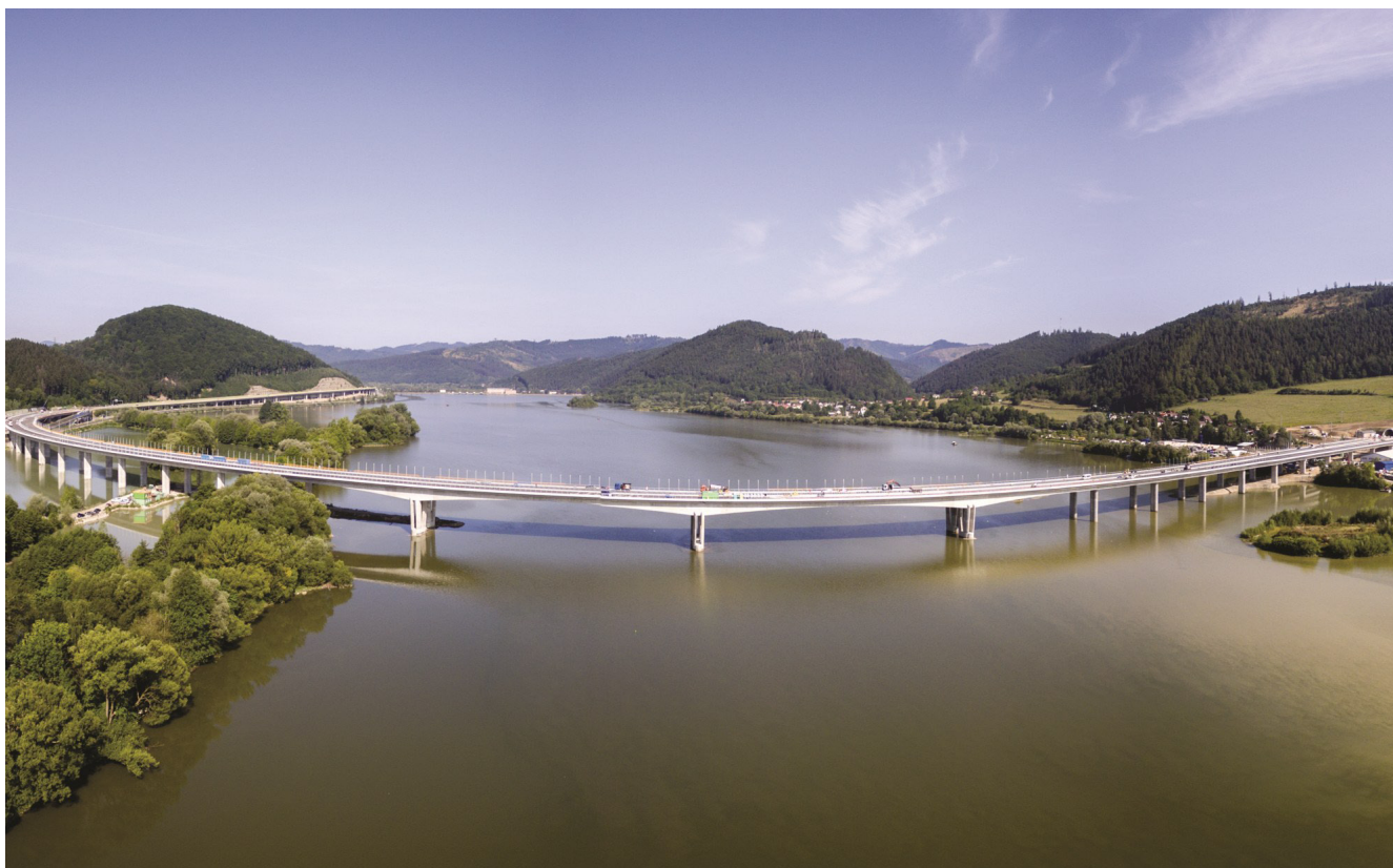
V súťaži Stavba roka 2017 hlavnú cenu získal úsek diaľnice D3 Žilina, Strážov - Žilina, Brodno (foto: Peter Koval', Vladimír Veverka)
